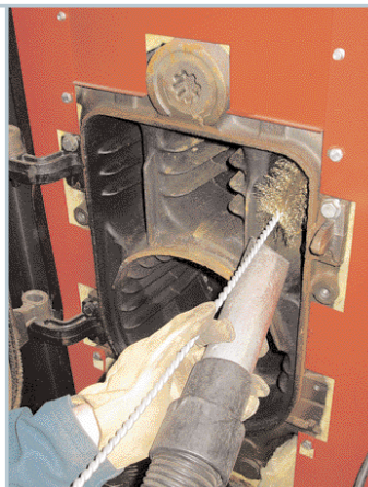
Obligatoire : nettoyage manuel avec des goupillons, des écouvillons, des brosses et un aspirateur pour finaliser le nettoyage chimique.
